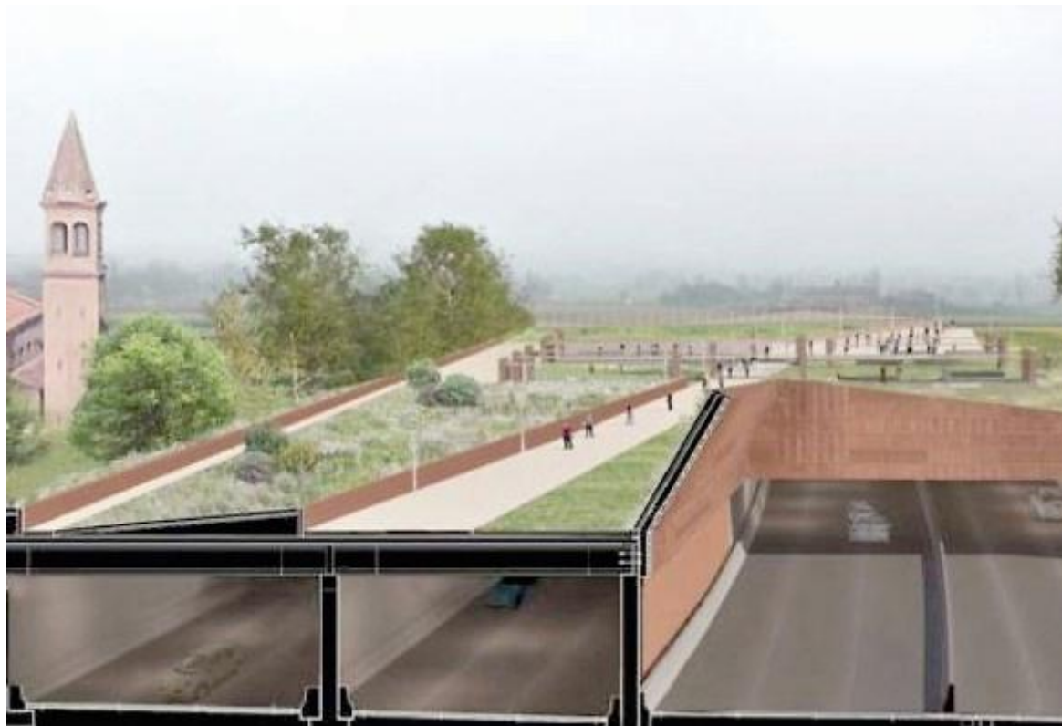
COME SARÀ Il rendering della galleria fonica nel tratto di Passante che attraversa San Donato
