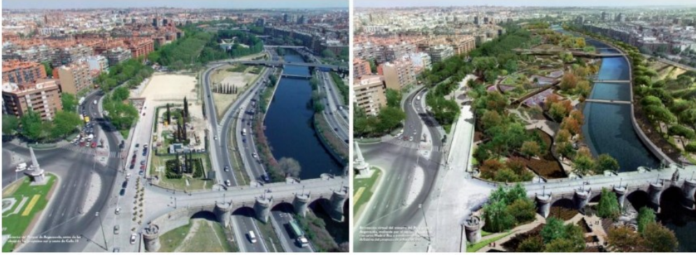
Rio Madrid, prima e dopo l'interramento dell'autostrada. È solo uno dei numerosi esempi di come in tutto il mondo le autostrade vengono eliminate dal tessuto urbano, interrando o deviandole in zone a bassa densità di popolazione.
